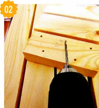
02 Перед сборкой засверлили отверстия под саморезы.
