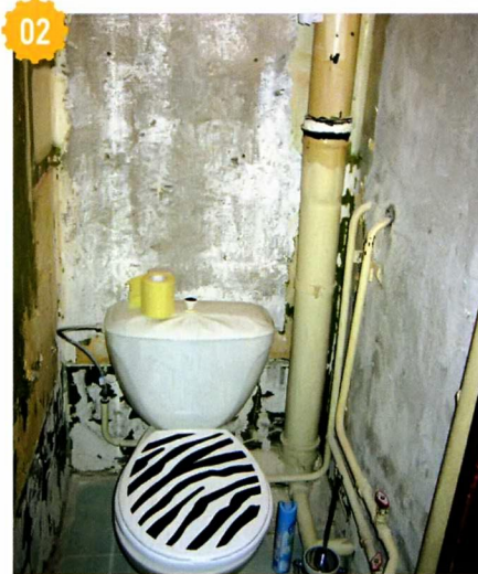
02 В процессе подготовительных работ было убрано всё лишнее.
