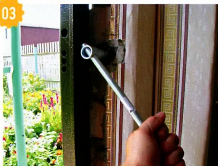
Рис. 1. Дверной проём дома. 1 — стальной уголок 50 × 50 мм.
