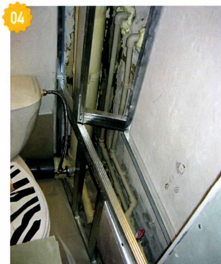
04 Старые трубы заменены на пластиковые. На пол и по низу стен уложена плитка.
